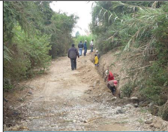
Refine de zanja de línea de conducción. Cabe recalcar que la población beneficiada coparticipa de manera decidida en la ejecución de este proyecto.
