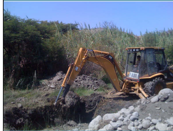
Excavación de galería filtrante. La empresa encargada de la obra es una empresa conformada por profesionales de Chavín.
