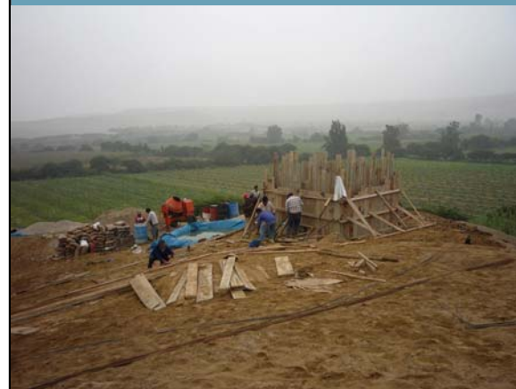
Construcción (vaciado) de reservorio. Al fondo parte del Valle de Topará.
