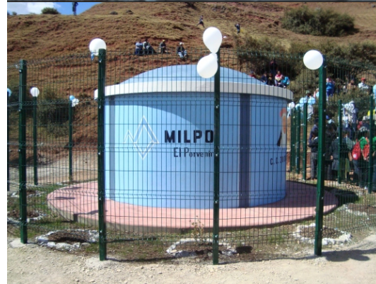
Vista del nuevo reservorio construido, posee uno de los cercos de seguridad más modernos.
