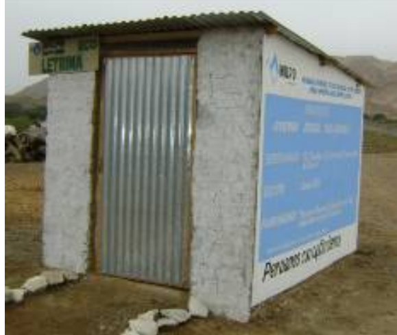
Letrina de hoyo seco, construida con materiales de la zona en la que participaron las familias con mano de obra no calificada.
