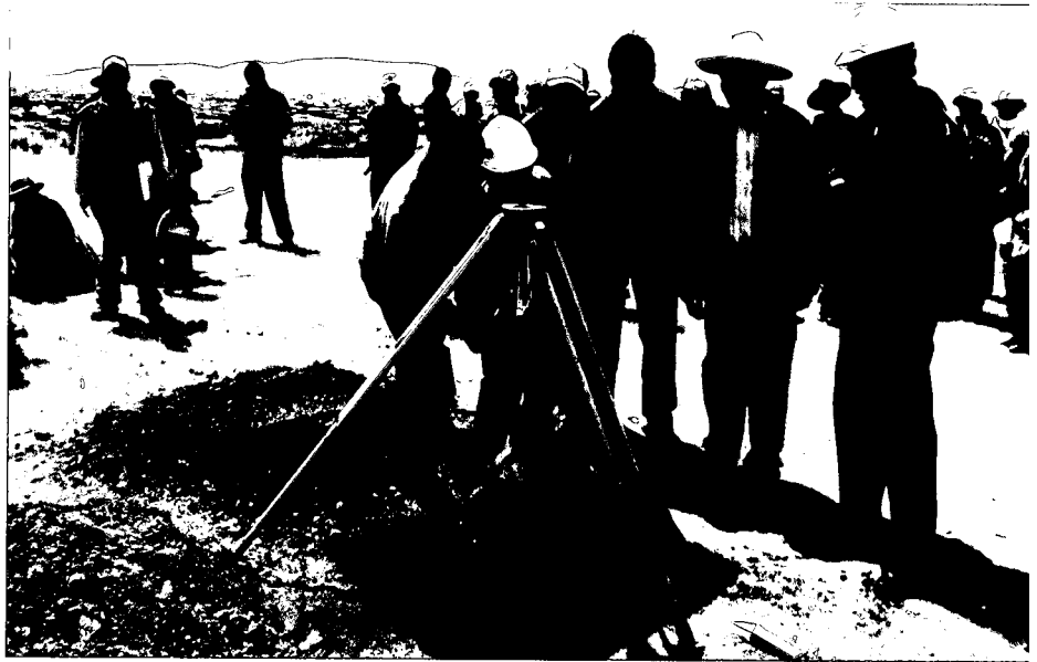
Puesta de la primera piedra para servicio de electrificación en el depósito de cobre Las Bambas de Xstrata al sur del Perú
